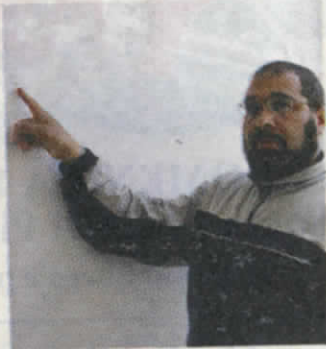
Ouatiq indica una crepa sul muro
