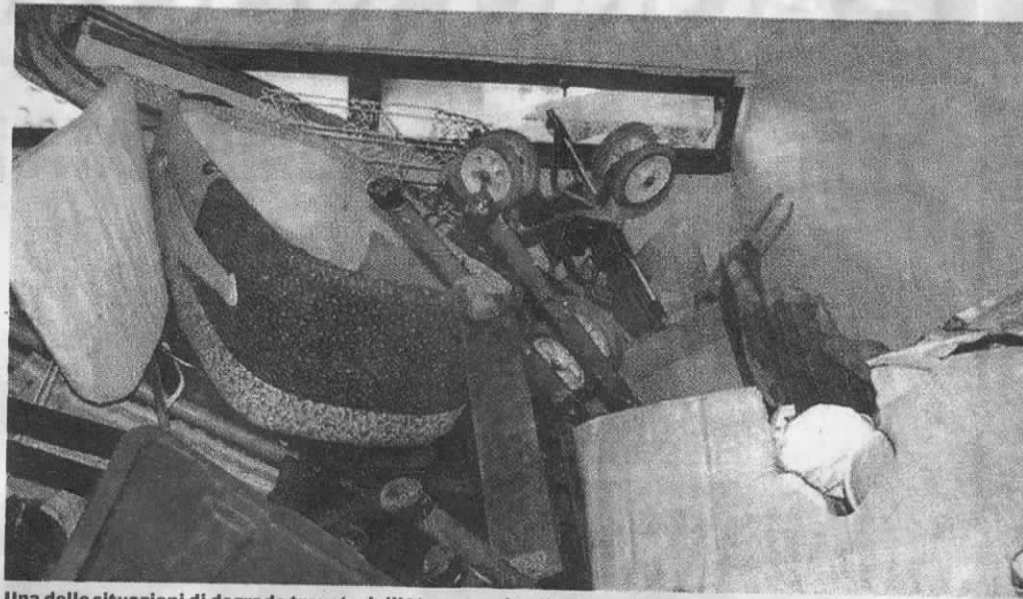
Una delle situazioni di degrado trovate dall'Ater a seguito di un'ispezione nelle case popolari
